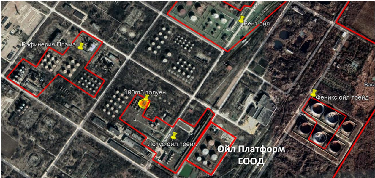
Фиг.4-5-4-4 Въздействие на пожара от повърхността на разлив от толуен върху площадката на „Лотус ойл трейд“ ЕООД и съседните обекти
