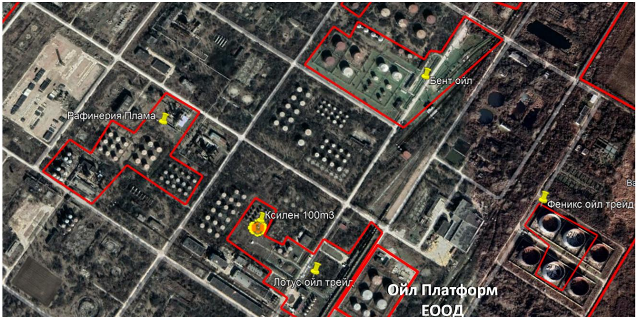
Фиг.4-5-2-2. Въздействие на пожара от повърхността на разлив от ксилен върху площадката на „Лотус ойл трейд“ ЕООД и съседните обекти
