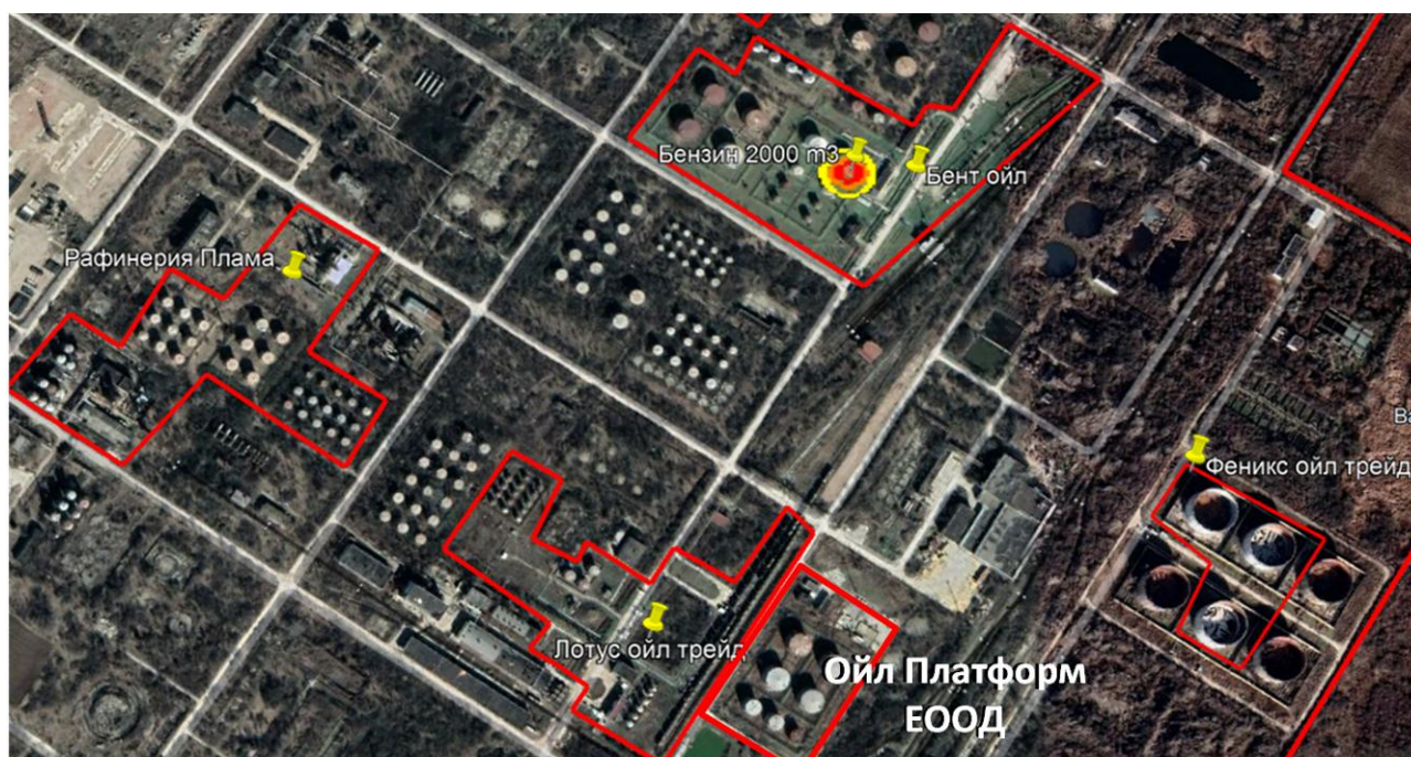
Фиг.4-5-6-2 Въздействие на пожара от повърхността на разлив от бензин върху площадката на „БЕНТ ОЙЛ“ АД и съседните обекти
